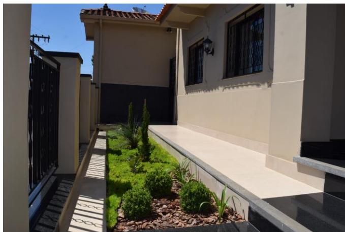
Imagem 03: Vista do imóvel a partir da escada de acesso. Fotografia de Jaíne Diniz Corrêa, dez/2023.
