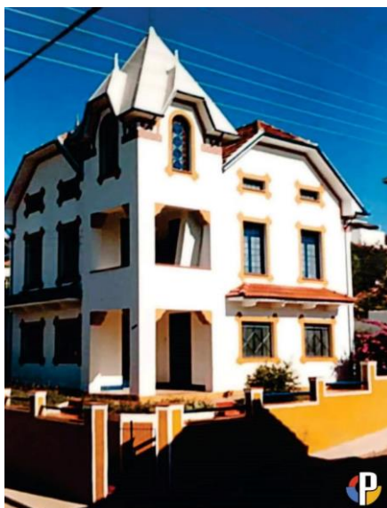
Imagem 01: Residência localizada na Rua XV de novem, nº 244, na década de 1980. Fotografia do acervo da Casa da Cultura de Machado.
