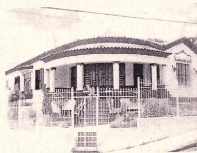
Figura 01 - Vista da fachada frontal. Autoria: Anderson Silva Data: janeiro de 2008 Acervo: Prefeitura Municipal
