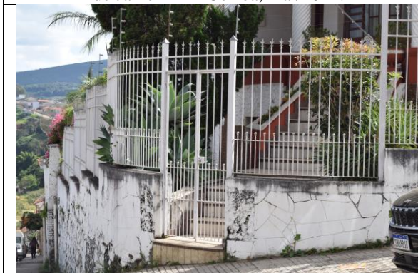
Imagem 03: Acesso ao imóvel. Fotografia de Jaíne Diniz Corrêa, mai/2024.
