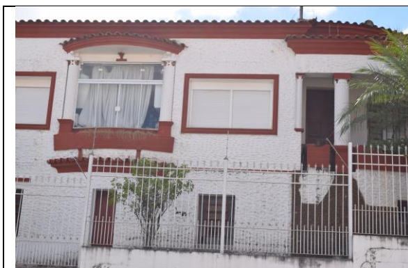
Imagem 05: Detalhes da fachada lateral. Fotografia de Jaíne Diniz Corrêa, mai/2024.
