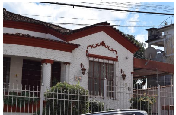
Imagem 04: Detalhes da fachada principal. Fotografia de Jaíne Diniz Corrêa, mai/2024.
