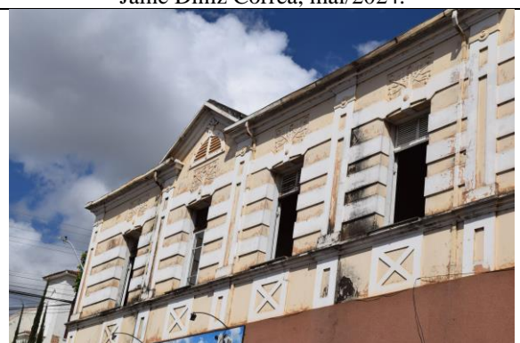
Imagem 04: Detalhes da fachada direita. Fotografia de Jaíne Diniz Corrêa, mai/2024.
