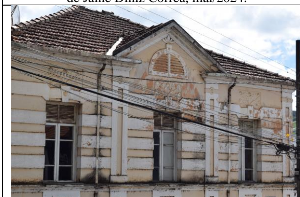
Imagem 03: Detalhes da fachada principal. Fotografia de Jaíne Diniz Corrêa, mai/2024.
