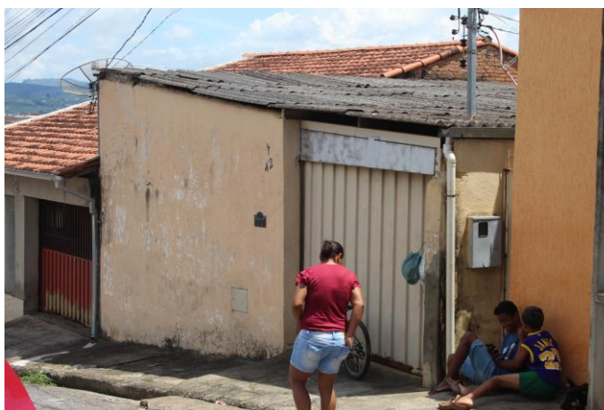
Imagem 01: Casa onde anteriormente o saber era realizado por Marcelo. Fotografia de Jaíne Diniz Corrêa, nov/2025. Seção 1 – Seção B
