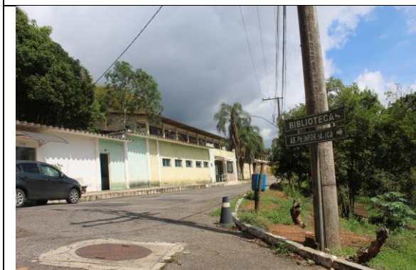
Imagem 03: Algumas das edificações do complexo. Fotografia de Jaíne Diniz Corrêa, nov/2025. Seção 1 – Seção B
