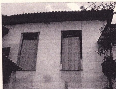
Detalhe da Fachada dos Fundos
