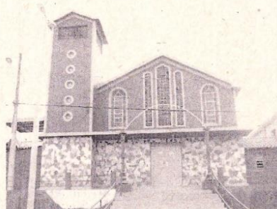
Figura 01 - Vista da fachada frontal. Autoria: Anderson Silva Data: janeiro de 2008 Acervo: Prefeitura Municipal
