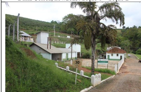
Imagem 06: Parte da estrutura. Fotografia de Jaíne Diniz Corrêa, nov/2025. Seção 1 – Seção B
