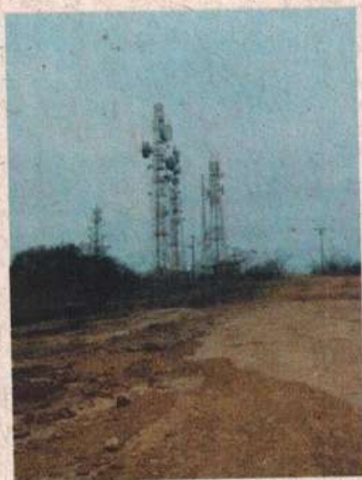
Vista das torres de transmissão instaladas no topo da serra.
