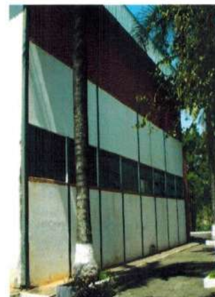
Fachada lateral direita
