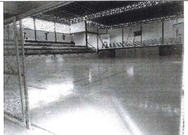
Imagem 04: Espaço interior do ginásio. Detalhe para o piso emborrachado, próprio para a prática esportiva, instalado no espaço na reforma ocorrida no ano de 2020. Foto: Hugo Rocha. Data: julho/2020.
