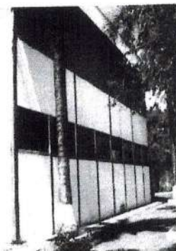
Fachada lateral direita
