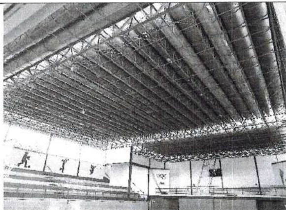
Imagem 05: Telhado da edificação, construído em estruturas metálicas, que foi totalmente reformado no ano de 2020. Foto: Hugo Rocha. Data: julho/2020.
