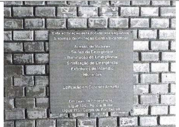
Imagem 06: Placa de informações de segurança, instalada no ginásio na reforma ocorrida no ano de 2020. Foto: Hugo Rocha. Data: julho/2020.
