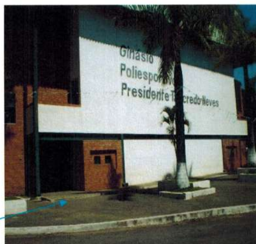
Vista frontal do Ginásio Poliesportivo.
