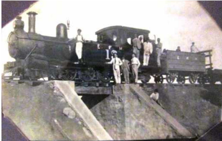
Locomotiva que transportou o material para a construção da estrada de ferro de Machado, 1923. Acervo da Casa da Cultura.
